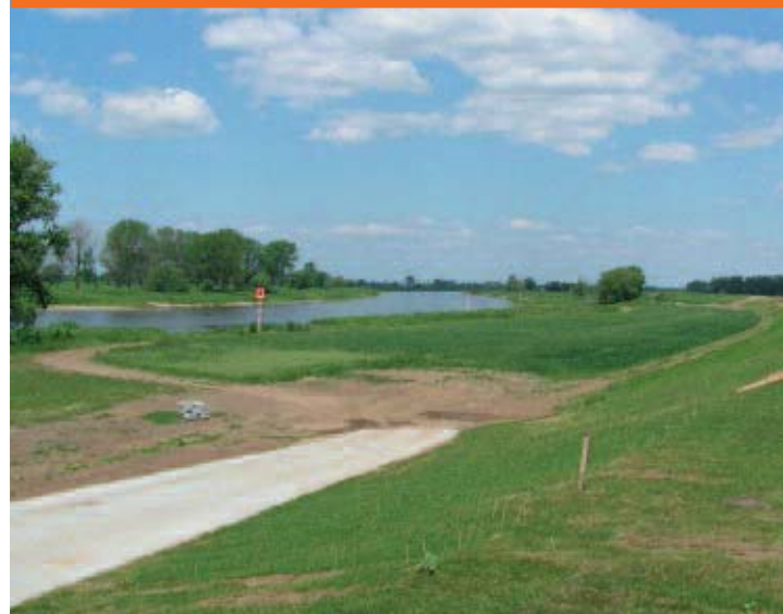
Hochwasserschutzdeich an der Elbe
