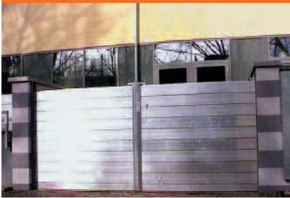
Umlaufender Hochwasserschutz mit teilmobilen Schutzelementen
